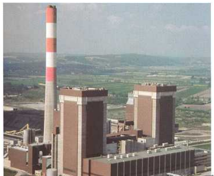
Kraftwerk Dürnrohr - Gesamtansicht
