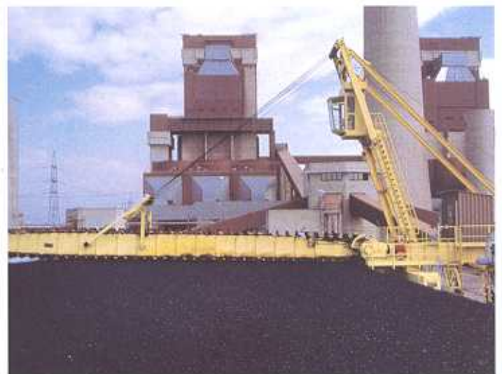
Kohlehalde mit Abbaukratzer.
