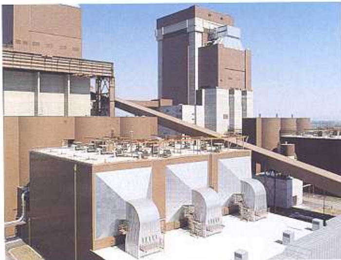
Elektrofilter (Außenansicht)
