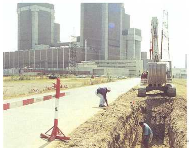
Grabarbeiten für Fernwärme-Hauptleitung
