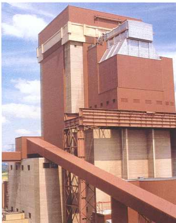
Kesselhaus des Blocks 1 (Verbundkraft)
